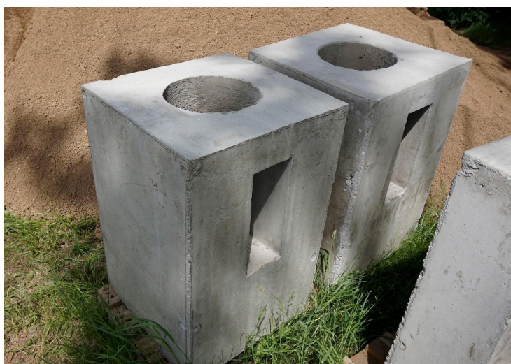
Obrázek 6 - Prefabrikované stožárové ŽB základy pro vetknutý stožár
